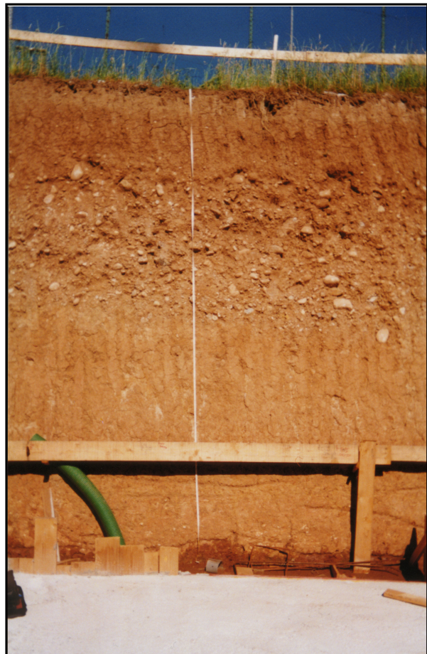
FOTO n.4 - Sezione di scavo 4 Cantiere via delle Rimembranze profondità 4.5 m
